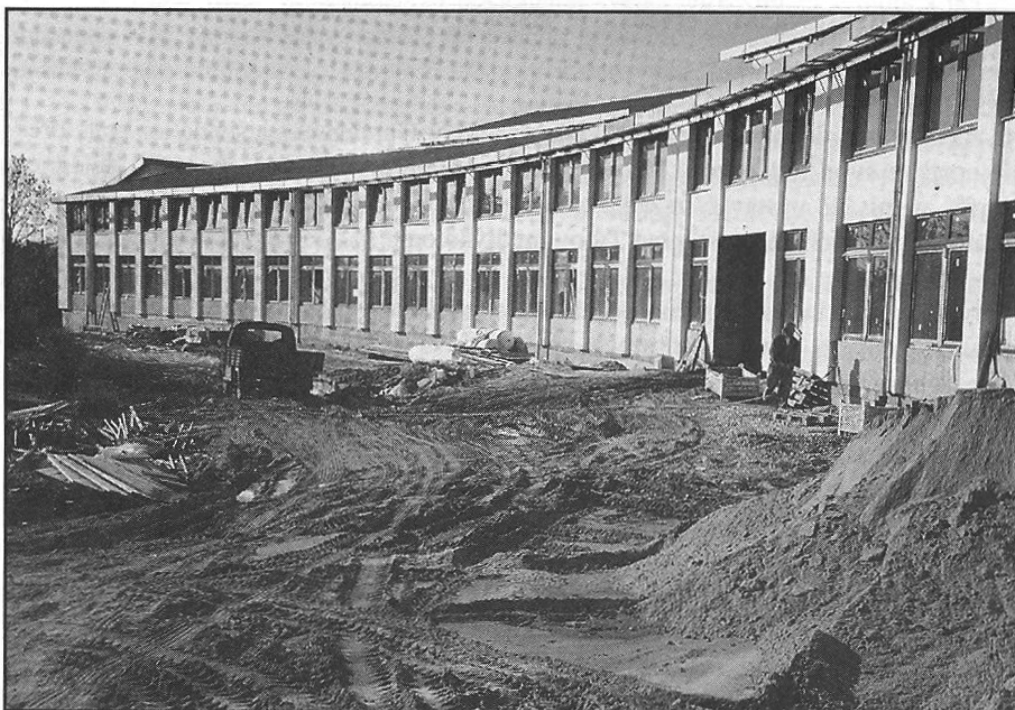
● Stavba nové školy
