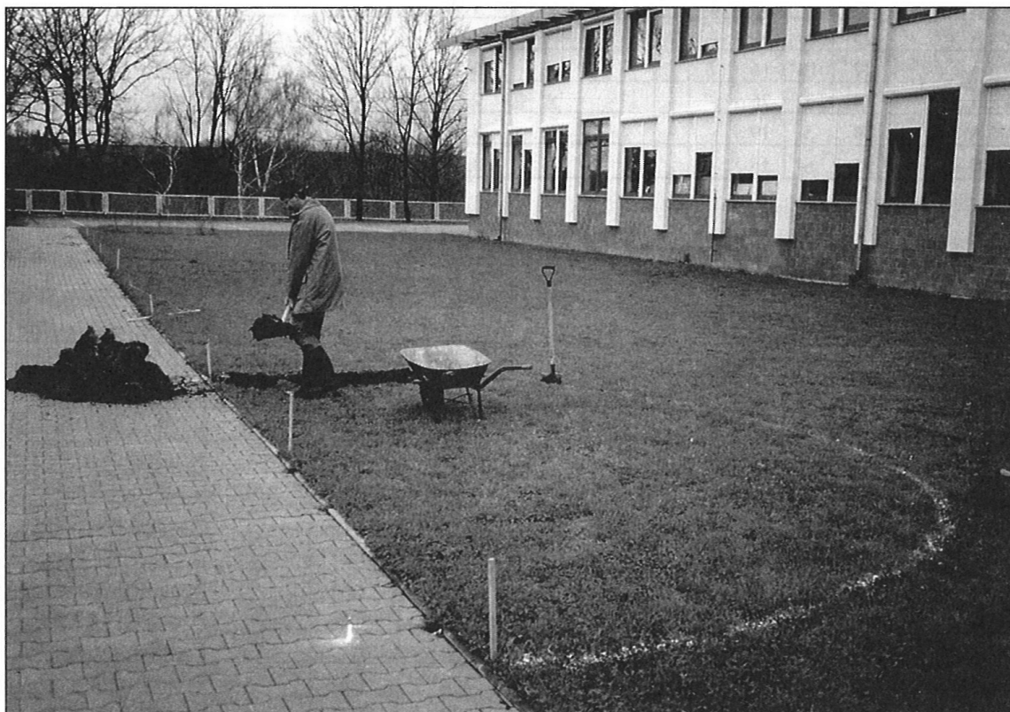
Začínáme budovat zahradu...
